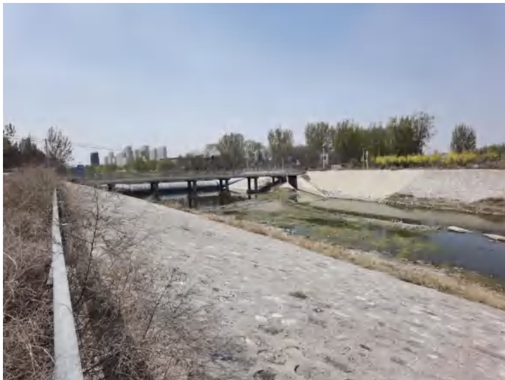
图 3.1-8 小甸屯村（G2 高速桥上游）凤河河段现状图
