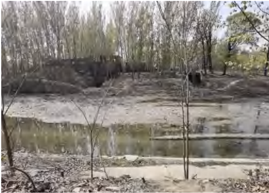
图 3.1-1 八干渠渠口与凤河交汇口现状图
