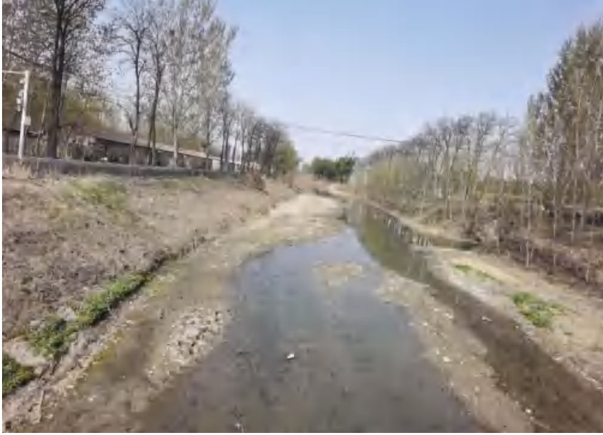
图 3.1-2 现状八干渠渠口下游现状图
