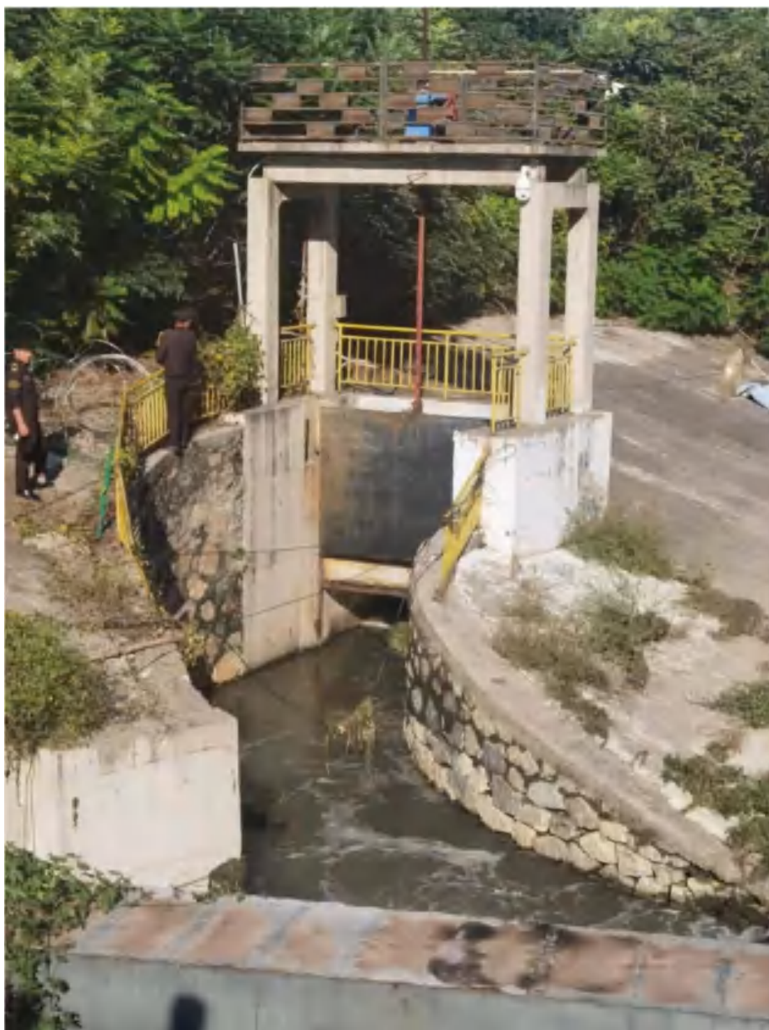
图 3.1-6 毕升桥下游涵洞进口现状图
