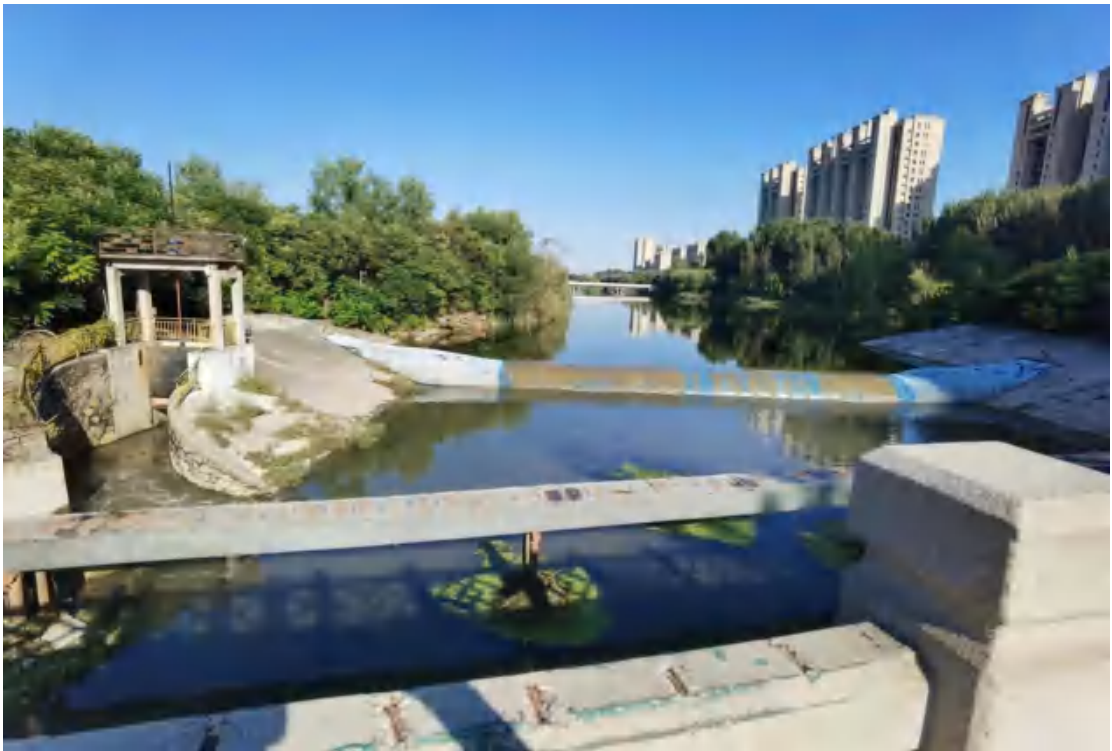
图 3.1-5 毕升桥下游橡胶坝现状图
