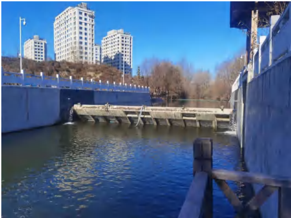
图 3.1-13 东尖塔钢坝现状
