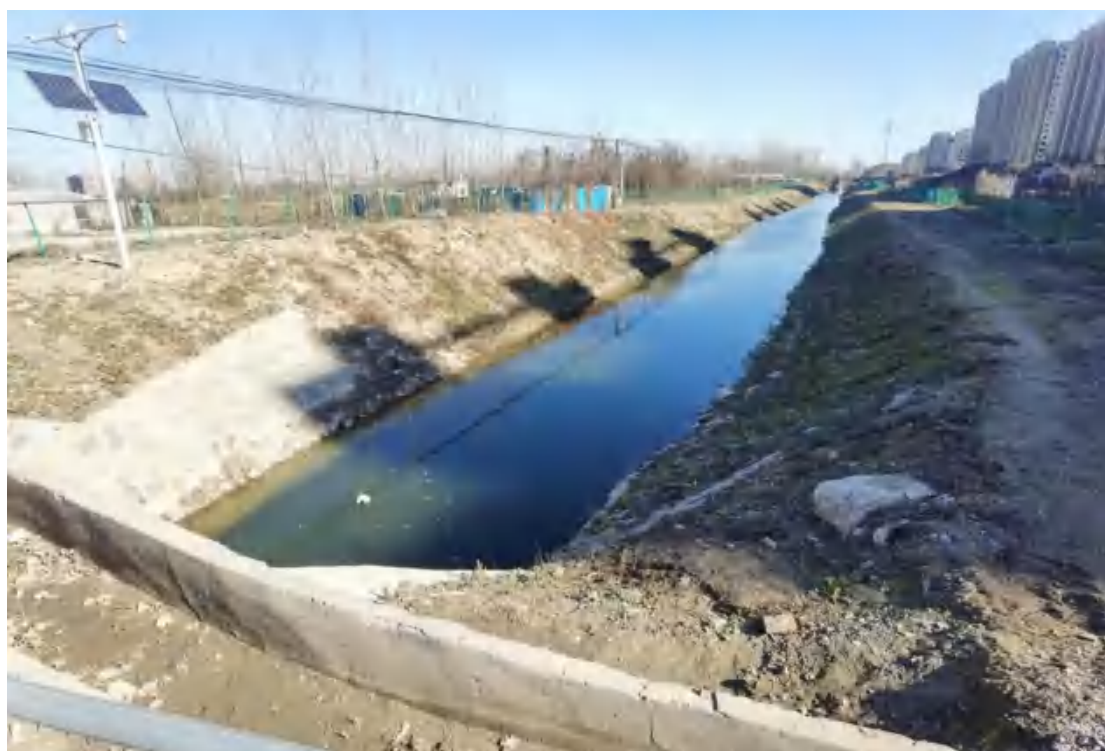
图 3.1-15 六干渠下游现状（八干渠方向）
