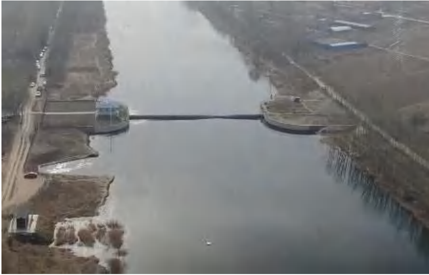
图 3.1-21 永丰橡胶坝现状
